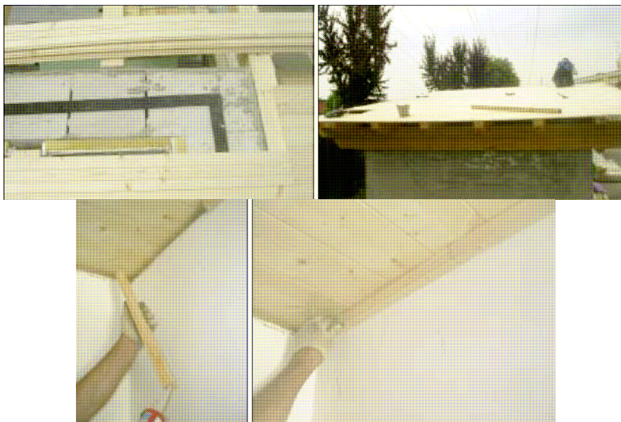
Figura 1 - Alcuni momenti della posa del primo assito e isolamento del giunto parete-assito.
