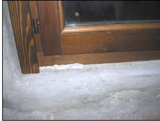
Figura 1 - Riempimento con stucco del nodo critico tra muratura e controtelaio.
